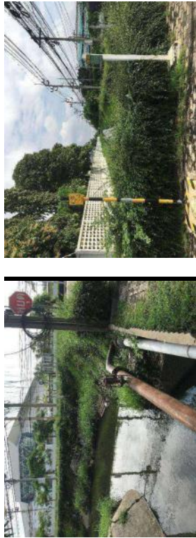
รูปที่ 6.1-24 แสดงท่อประปา และท่อแก๊ส เป็นอุปสรรคการปรับปรุง Box culvert บริเวณซอย 3B
